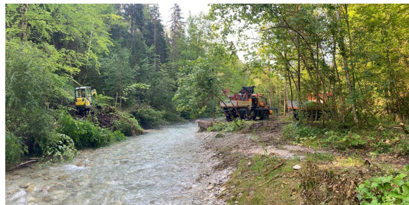
➤ Bauarbeiten im Zinkgraben
