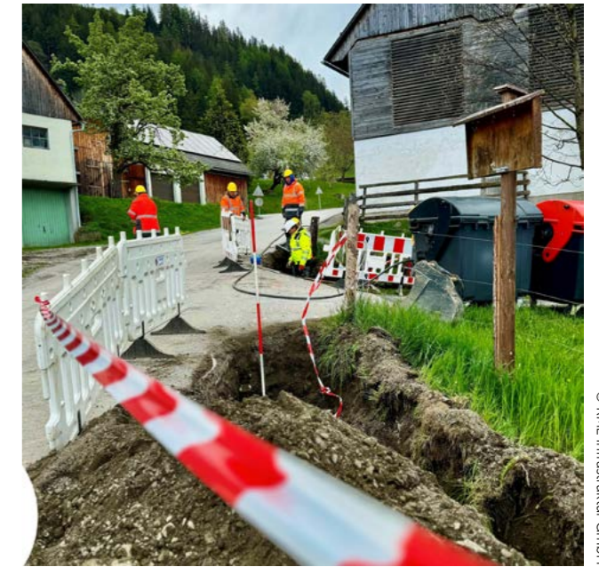
➤ Glasfaserausbau in der Gemeinde Aigen im Ennstal
