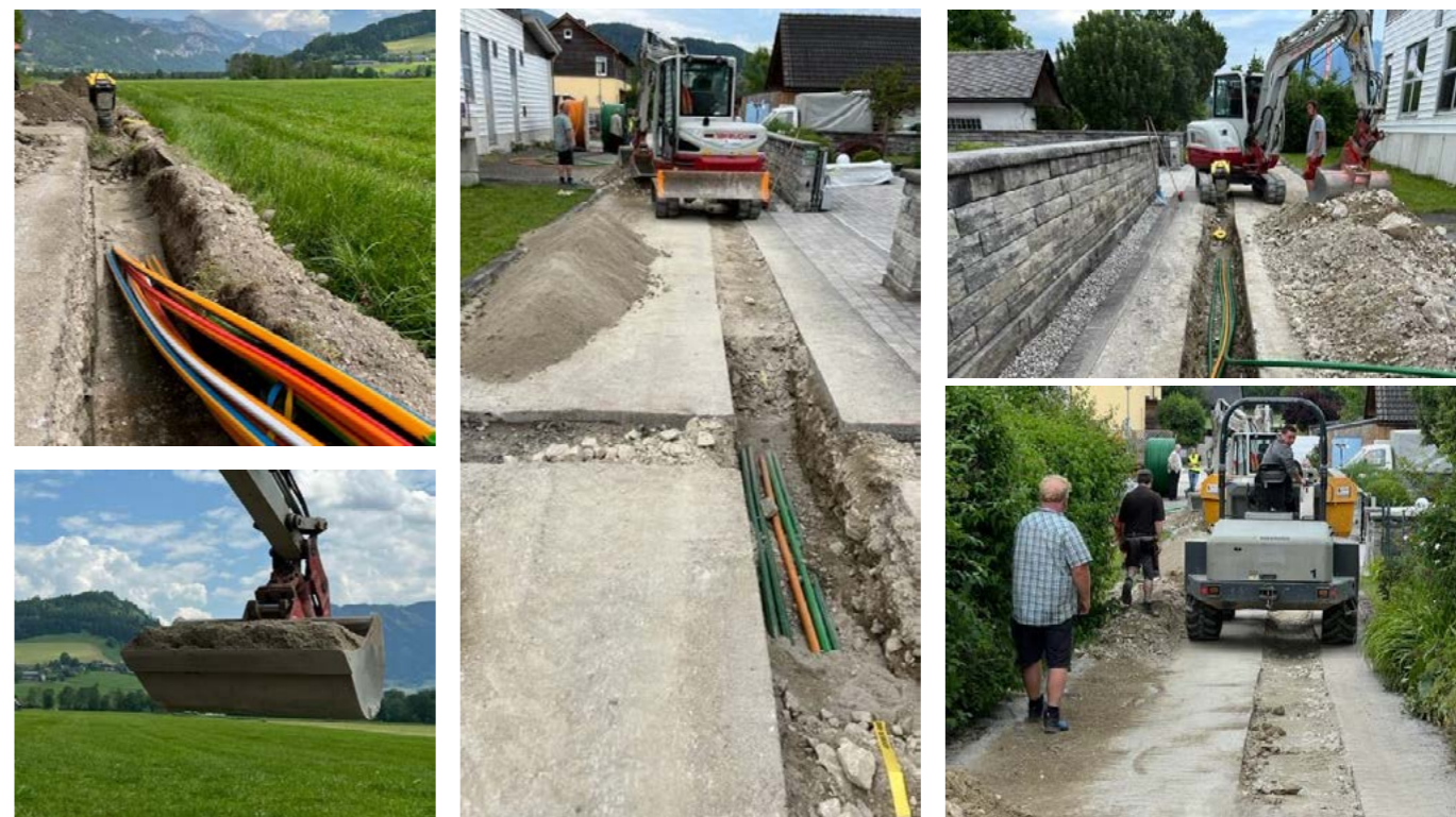
➤ Eindrücke vom Glasfaserausbau in den Gemeinden Irnding-Donnersbachtal und Aigen im Ennstal im Mai 2023.
