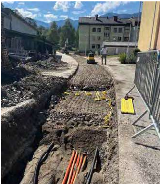
Bis 2025 werden 1600 Kilometer Glasfaserkabel im Bezirk Liezen verlegt. Foto: RML/Enrico Radaelli
