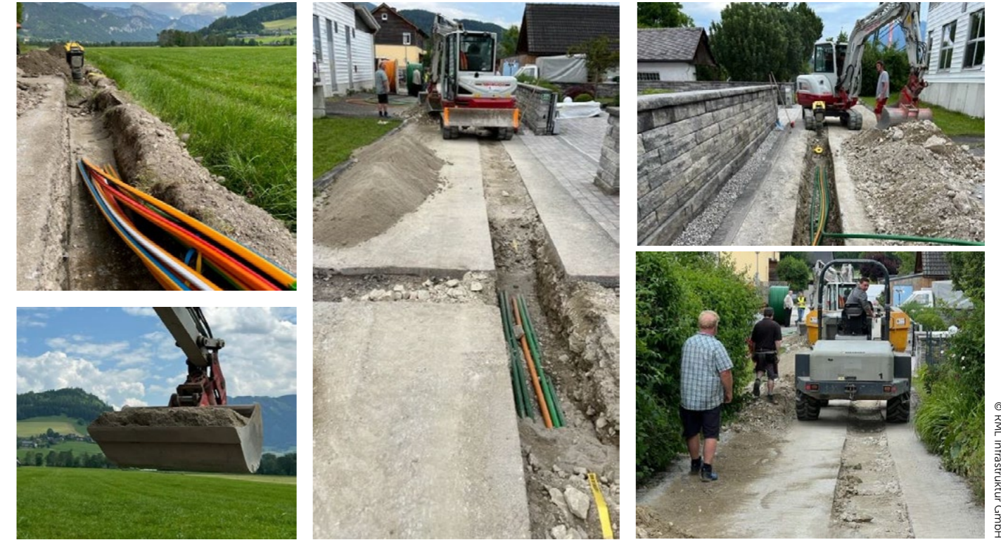
➤ Impressionen von den Bauarbeiten in Irdning-Donnersbachtal.
