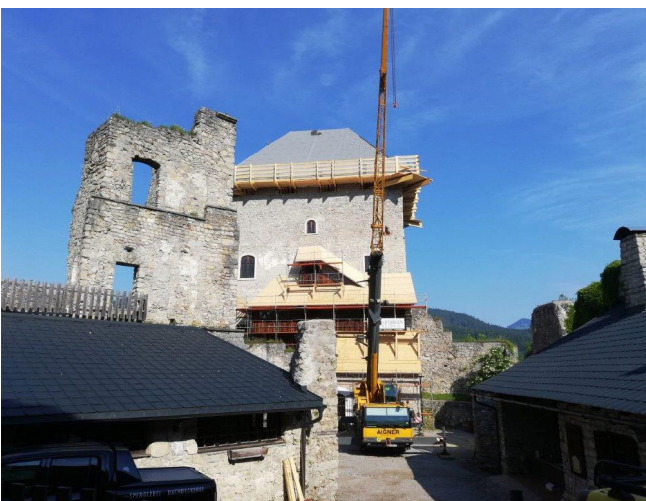
Instandsetzung der Burg Gallenstein © Marktgemeinde St. Gallen
