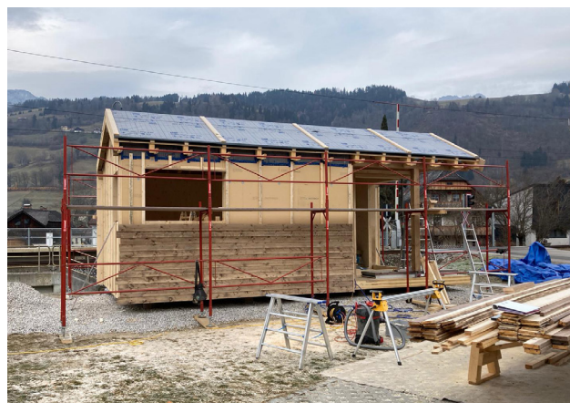
➤ Bauphase der Marktbox in Pruggern, Gemeinde Michaelerberg-Pruggern (Stand: Oktober 2020)
