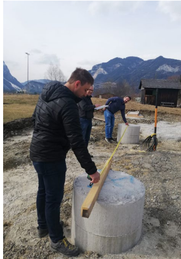
➤ Bei der Baubegehung mit der neu beauftragten Holzbaufirma im April 2022 wurden die Weichen für den Neustart gestellt.
